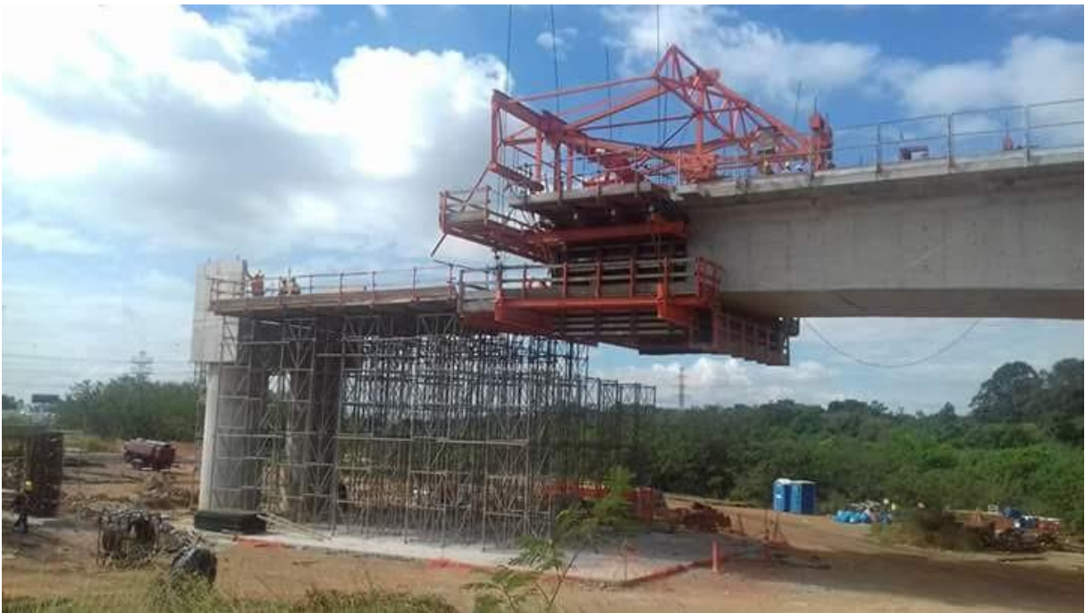
Figura 03: Mostra na pratica cimbramento X balanço sucessivo
