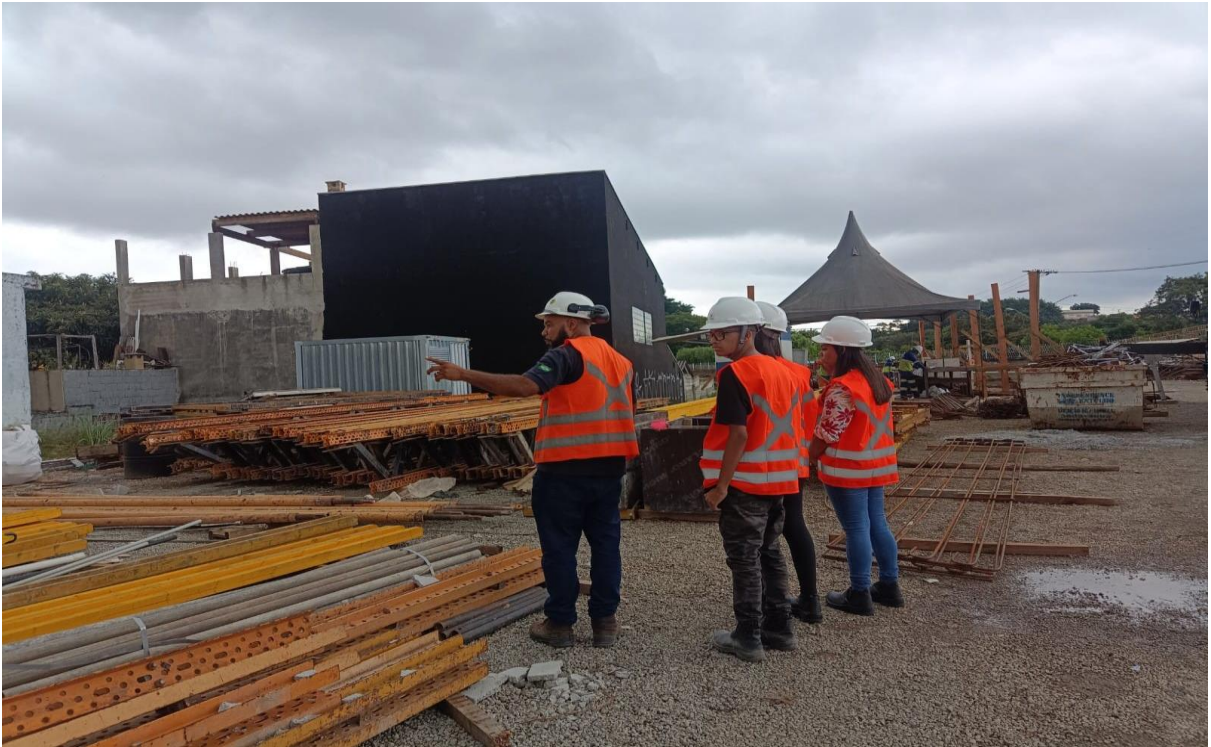
Figura 08: Canteiro de obra
