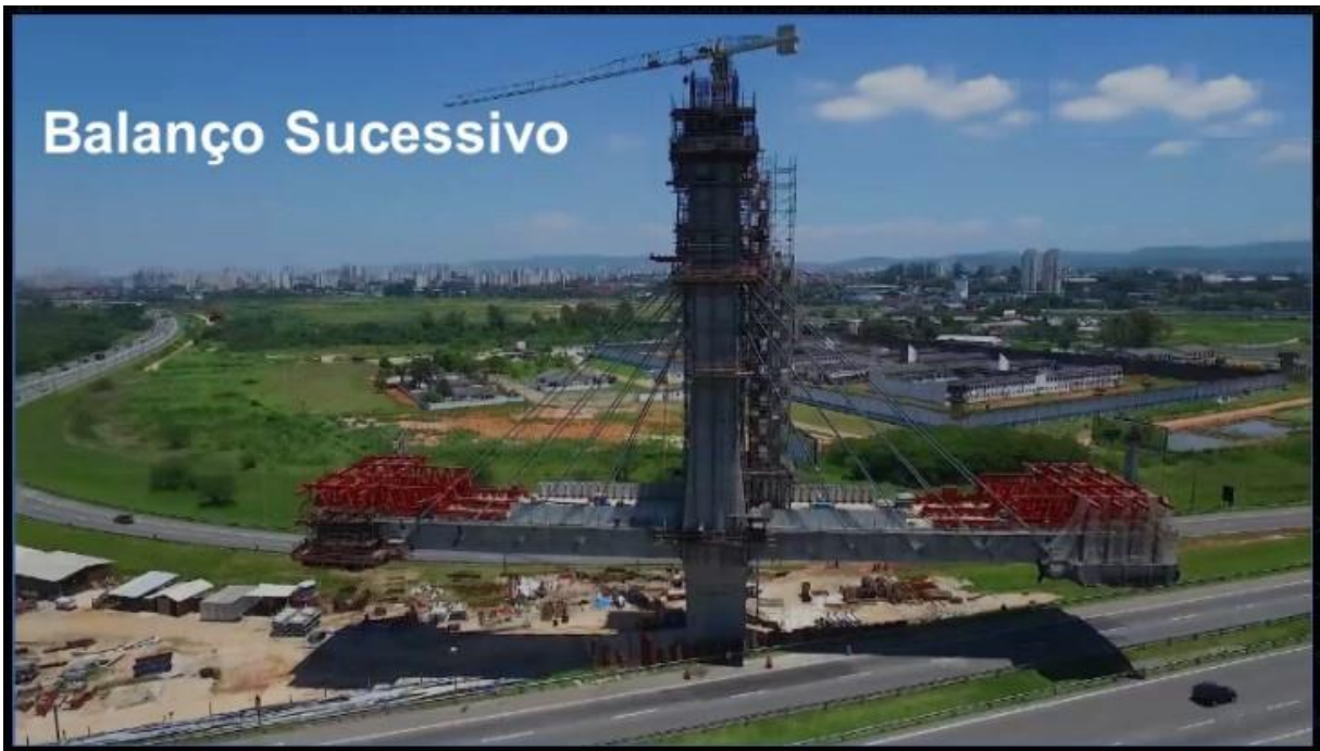
Figura 02: Exemplo do funcionamento (Carro de Avanço)
