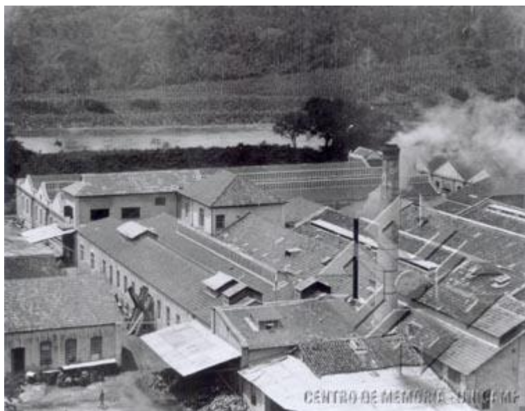
Figura 01 - Vista parcial da fábrica. Campinas, Villa Americana, SP, 1920, O.R. Quas Phot. Coleção Carioba (Fonte: Arquivo Edgard Leuenroth-Unicamp)
