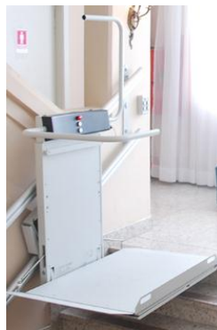
Figura 7 - Plataforma de acessibilidade para escadas
