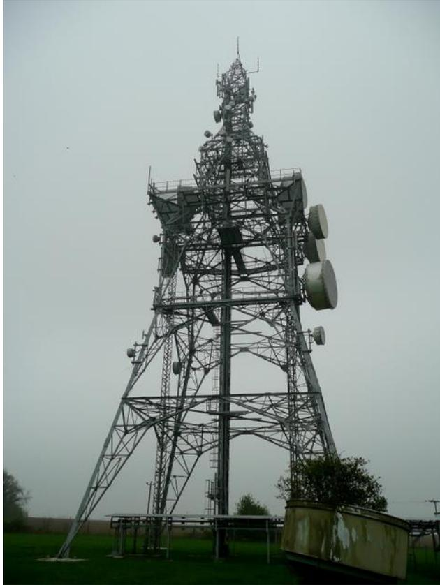
FIGURA 2 – Torre com equipamentos emissores/receptores de micro-ondas.
