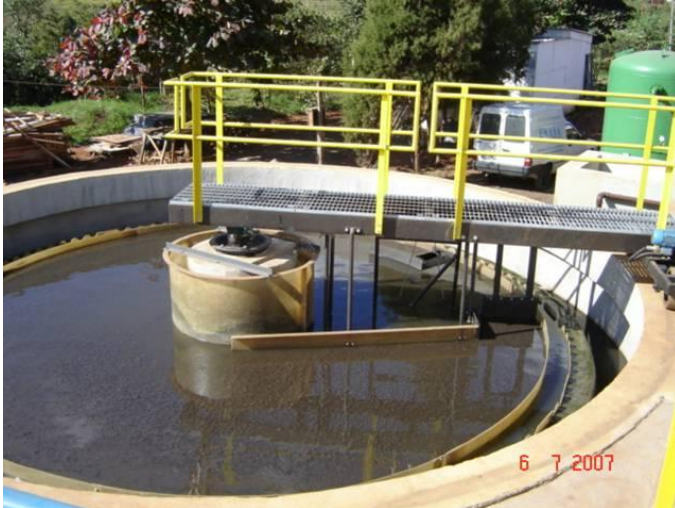
Figura28 – decantadores circulares.
