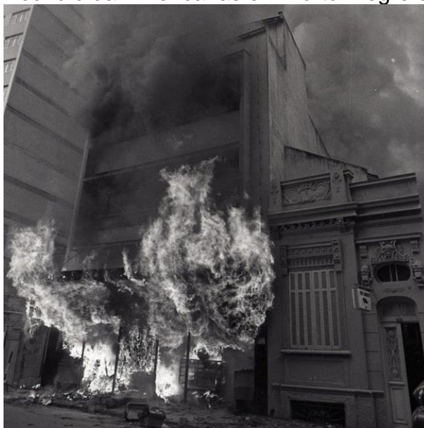
Incêndio da Americanas em Porto Alegre em 1973
