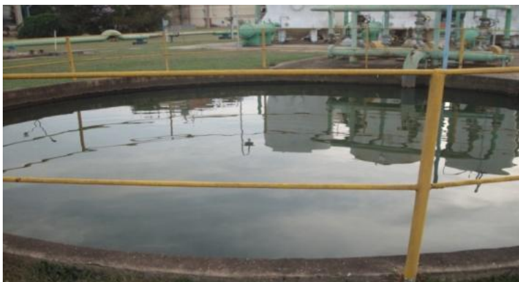
Figura 32: Tanque de água bruta após a captação do rio Piracicaba.
