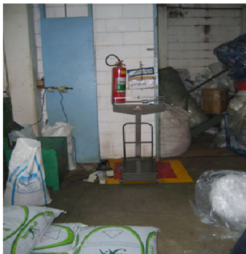
Figura 9- Dificuldade no acesso ao extintor de incêndio
