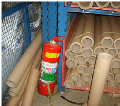
Figura 9- Dificuldade no acesso ao extintor de incêndio
