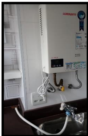
Figura 65 - Ambiente antes da montagem
