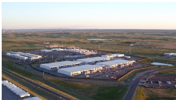
Figura 2 - Datacenter Microsoft Arizona EUA
