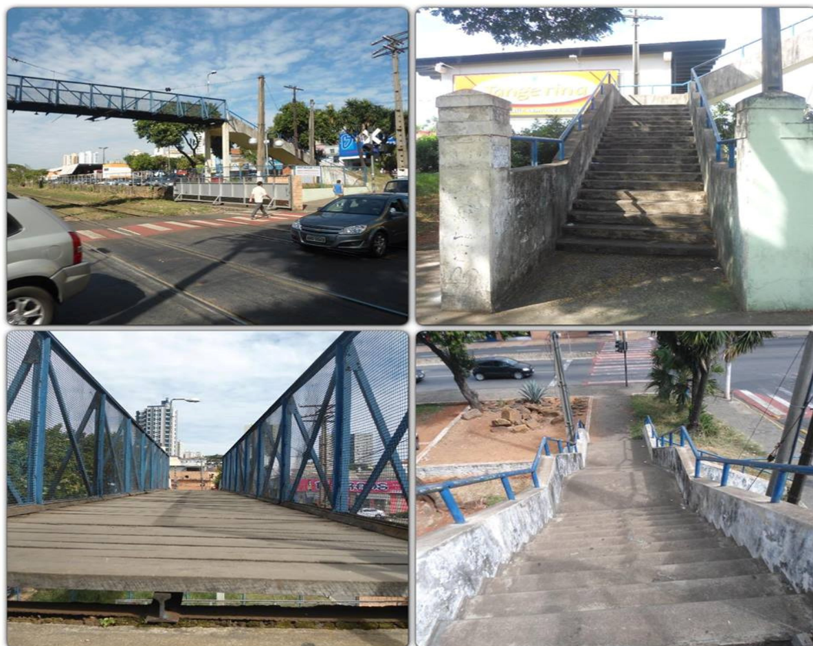
Figura 7: Passarela sobre a linha na passagem da Rua Carioba
