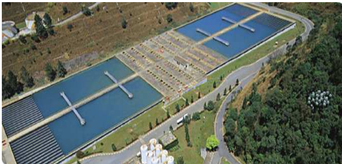
Figura 2: Estação de Tratamento de Água. Fonte: GOOGLE IMAGENS (2013).
