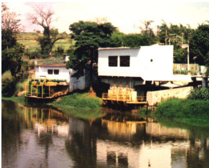
Figura 4 - Estação de Captação de Água Bruta Fonte: DEPARTAMENTO DE ÁGUA E ESGOTO DE AMERICANA (2013).
