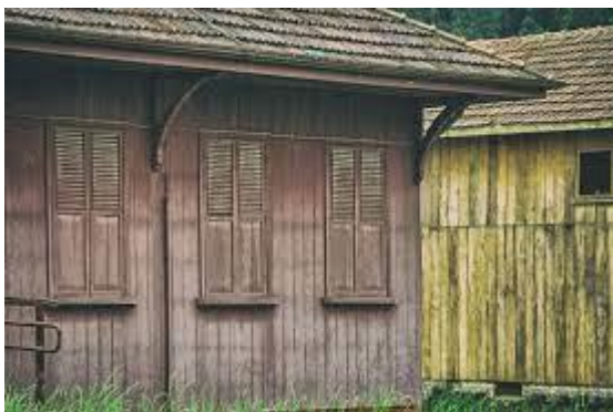
Figura 2 - Construções em madeira
