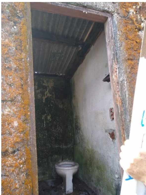
Figura 9 – Interior do anexo de alvenaria
