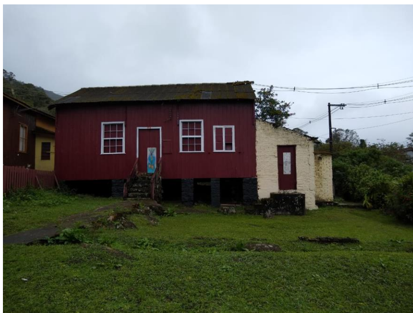
Figura 7 - Construção Híbrida (madeira e alvenaria)
