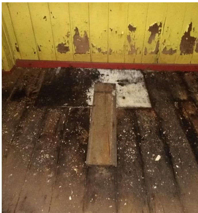
Figura 7 – Assoalho de madeira
