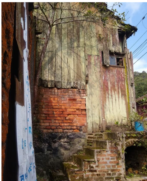
Figura 8 – Anexo de alvenaria
