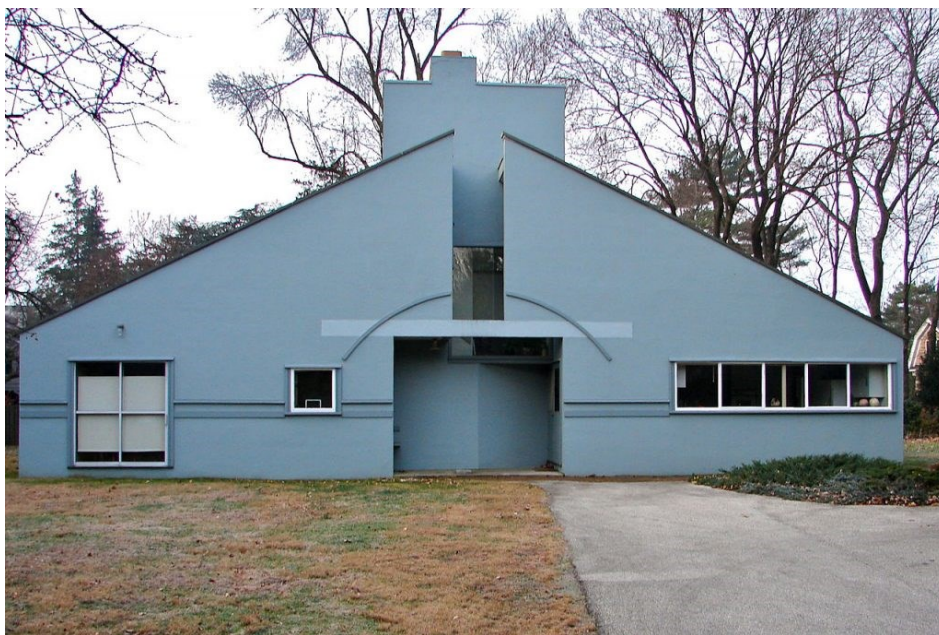
Imagem 74 – Casa Vanna Venturi
