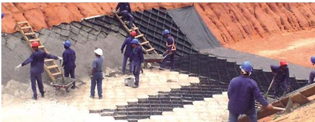
Imagem 13. Nãotecidos Geofort, sendo aplicados para contenção. Fonte: Site da empresa estudada.
