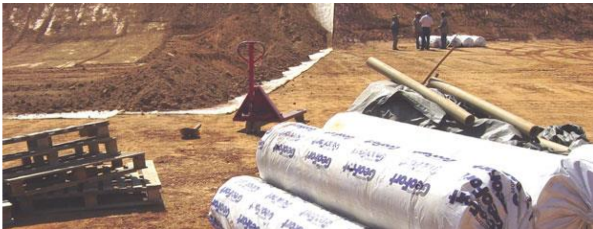
Imagem 12. Nãotecidos Geofort, sendo aplicados em aterro. Fonte: Site da empresa estudada.
