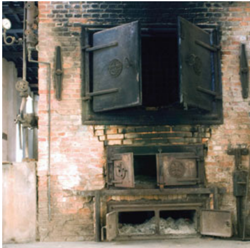
Figura 1: Caldeira para queima de lenha, para produção de vapor, Fábrica São Luiz. Fonte: http://revistapesquisa.fapesp.br .
