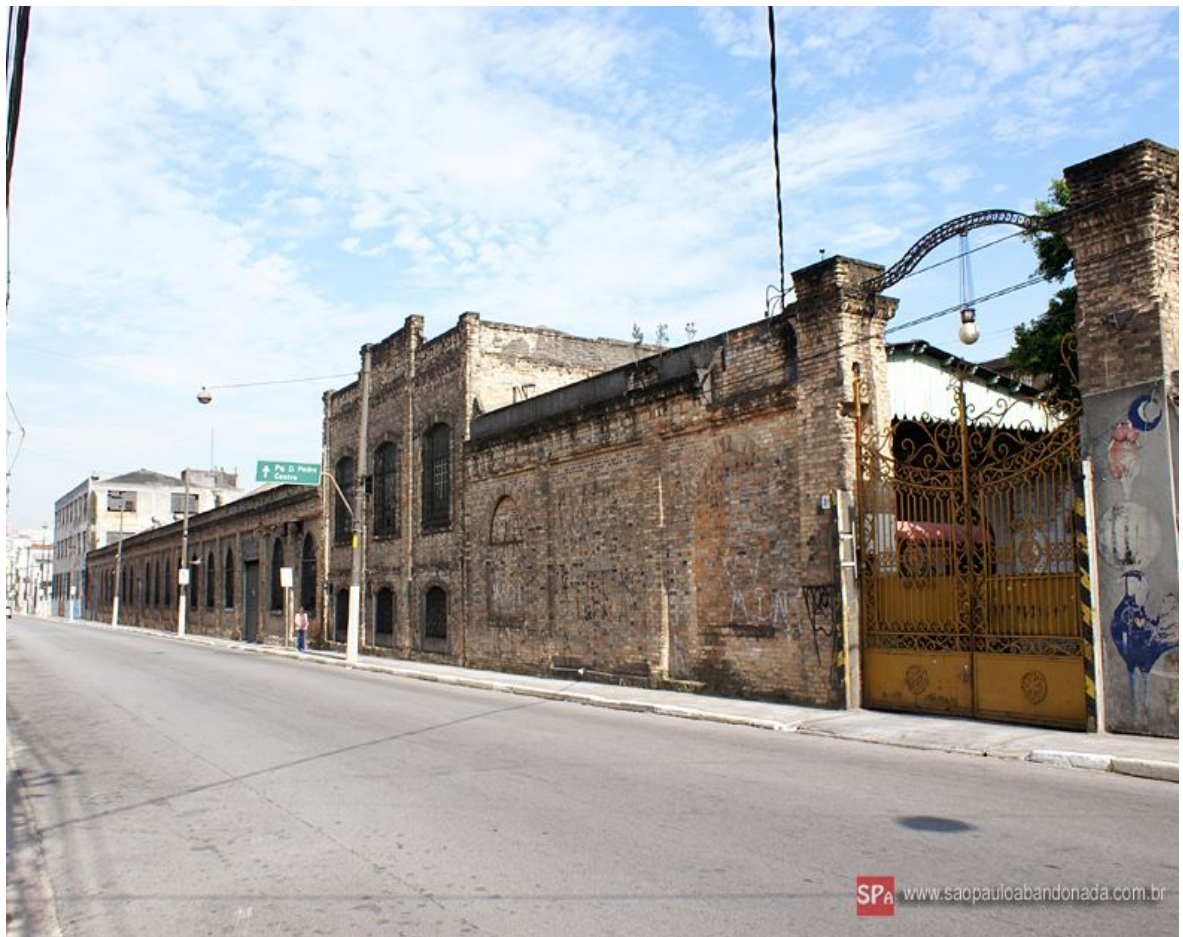
Figura 4: Prédio da Antiga Fábrica de Tecidos Labor S/A, na Mooca, SP. Fonte: arquivo Gabriela Gonçalves - http://www.saopauloantiga.com.br .
