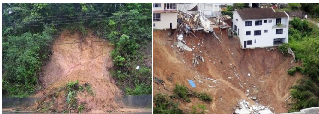
Figura 5.3: Deslizamentos de terra.
