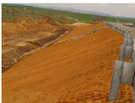
Figura 5.7: Estabilização de solo. Fonte: Site Civil Press (2013).
