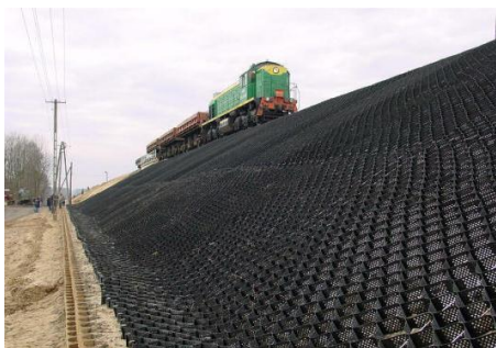
Figura 5.8: Tratamento de talude. Fonte: Site Wall Muro (2013).
