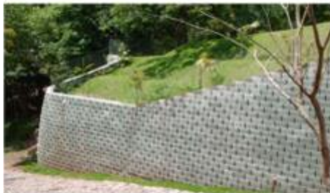
Figura 5.5: Muro de arrimo. Fonte: Site Obergeo (2013).
