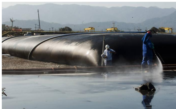
Figura 2.10: Geotubo utilizado para descontaminação. Fonte: Site Folha de São Paulo (2013).
