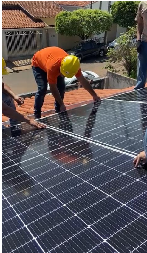
Figura 35 – Imagem da instalação das placas
