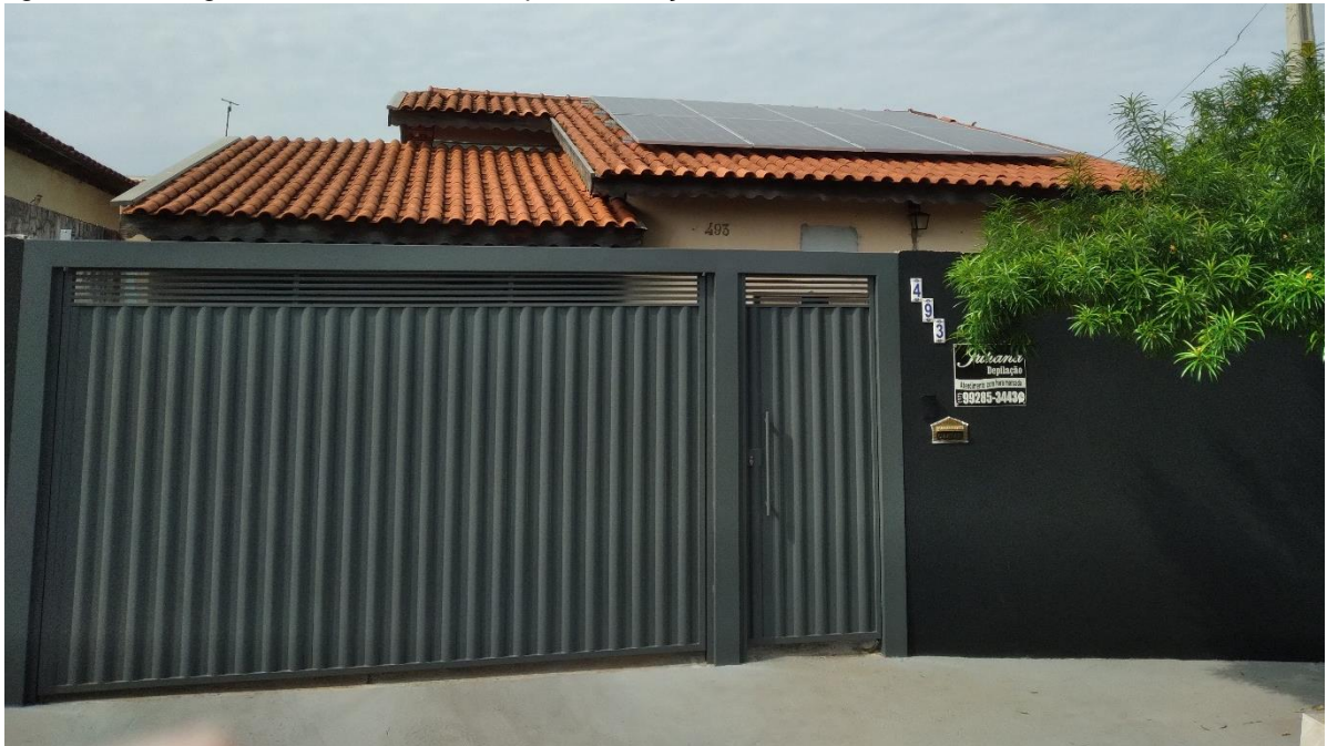
Figura 37 – Imagem da casa e telhado após instalação
