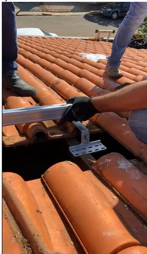
Figura 33 – Imagem da instalação do trilho
