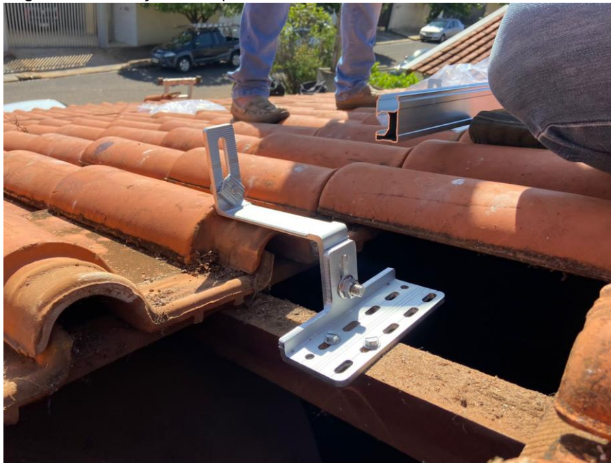
Figura 33 – Imagem da instalação do trilho
