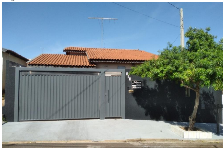
Figura 27 – Imagem da casa e telhado
