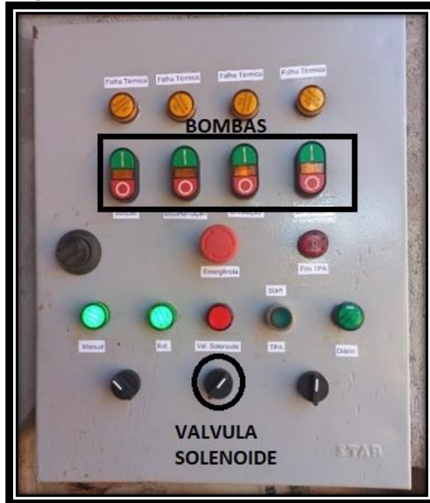
Figura 43: Botões da Bomba e da Válvula Solenoide
