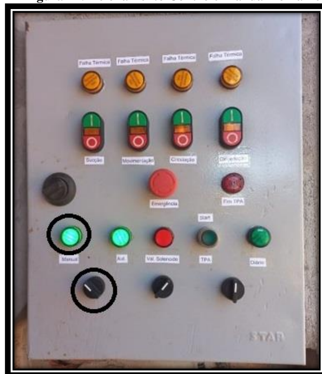
Figura 42: Acionamento Controle Manual no Painel
