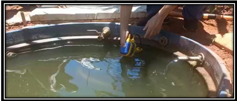
Figura 56: Ajustes na Boias
