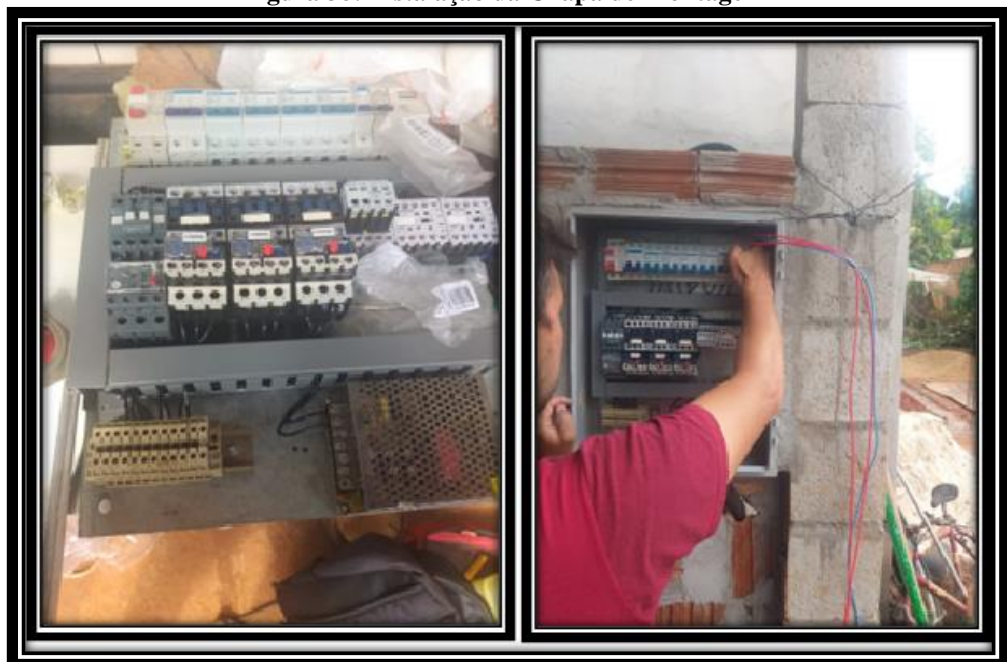
Figura 38: Instalação da Chapa de Montagem
