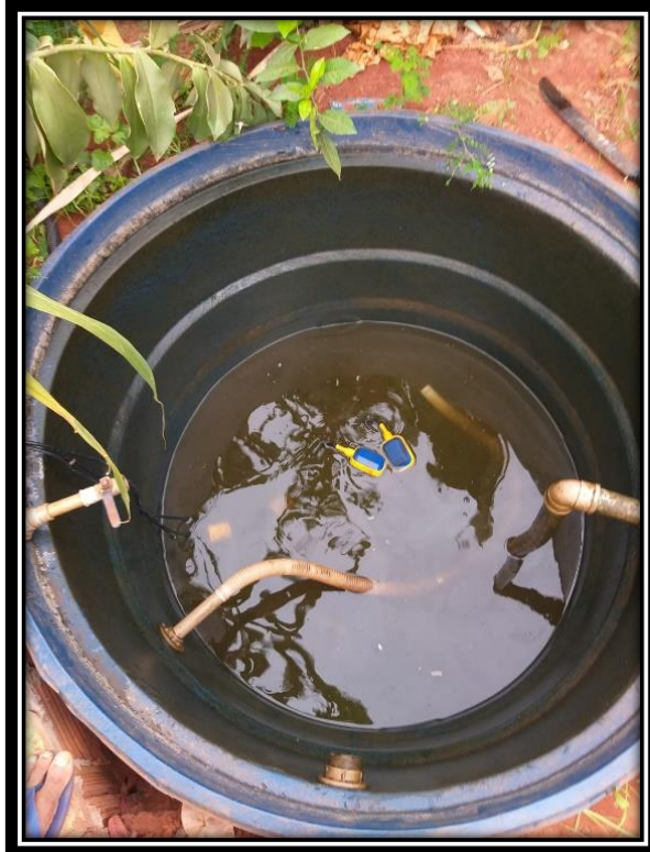
Figura 31: Boias B2 e B3 no Decantador Principal
