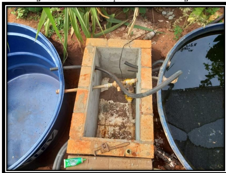
Figura 33: Bomba de Sucção na Caixa de Passagem
