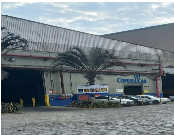
Figura 19: Terminal Açucareiro Copersucar.
