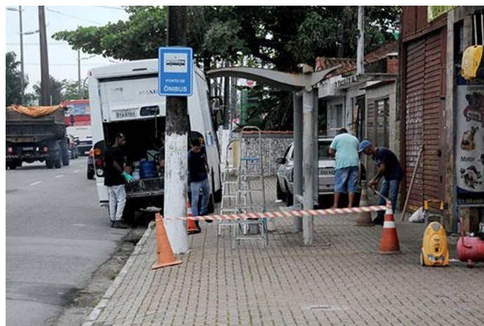
Figura 9: Manutenção de pontos em Praia Grande
