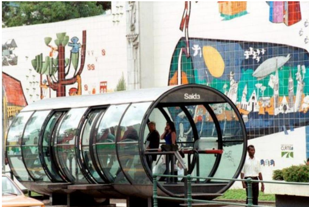
Figura 16: Estação-tubo em Curitiba
