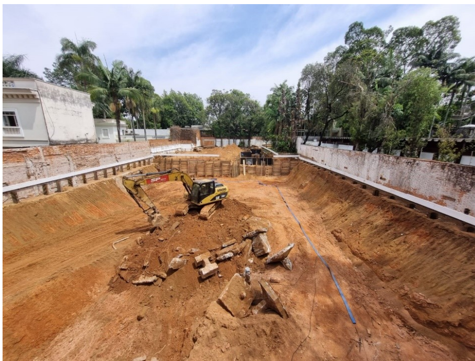
Figura 31 - Visão Geral da Obra Rua Espanha
