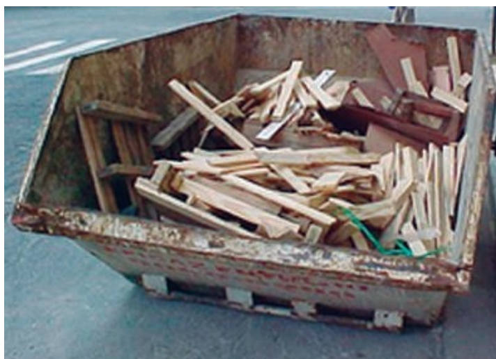
Figura 25 - Caçamba estacionária contendo resíduo de madeira
