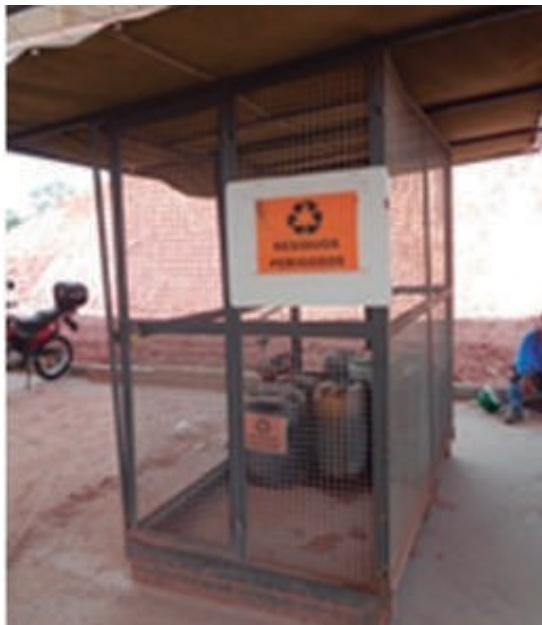
Figura 24 - Abrigo para resíduos perigosos com bombonas
