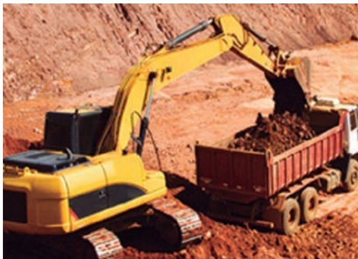
Figura 26 - Retirada de terra em caçamba basculante
