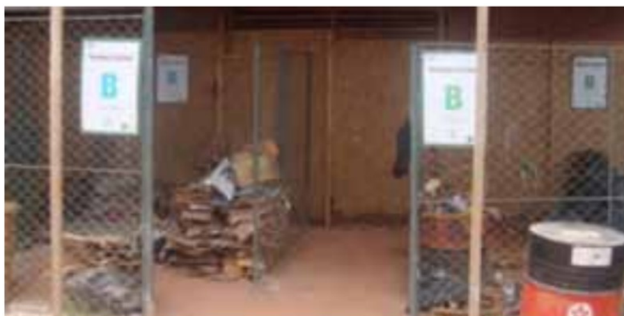
Figura 16 - Segregação de RCD no canteiro de obras
