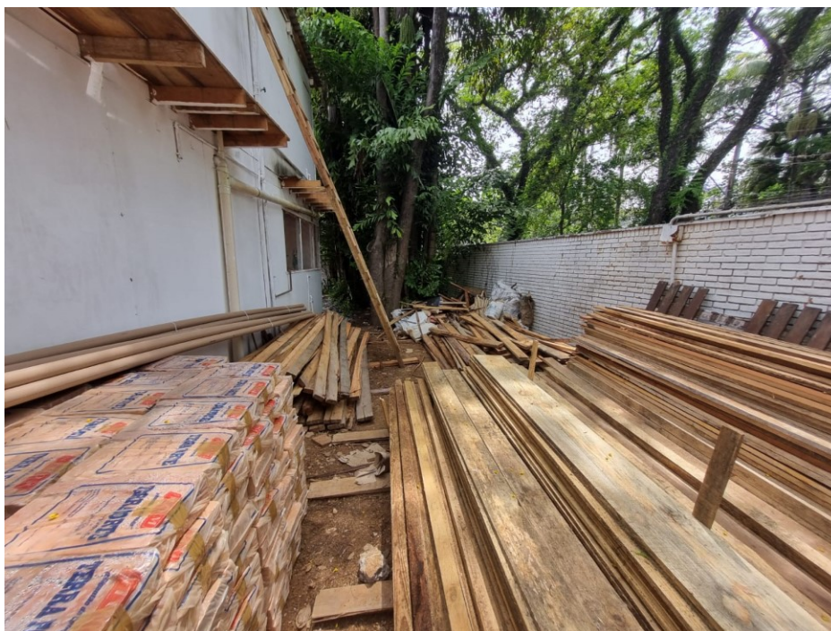
Figura 32 - Armazenamento de Sobras de Madeira da Obra Rua Espanha
