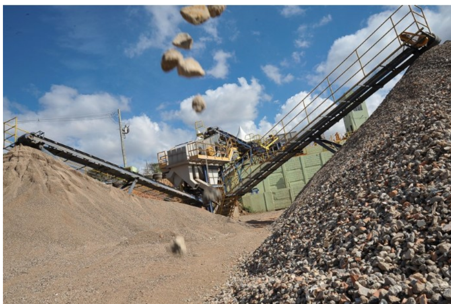
Figura 19 - Estação de Reciclagem de Entulho
