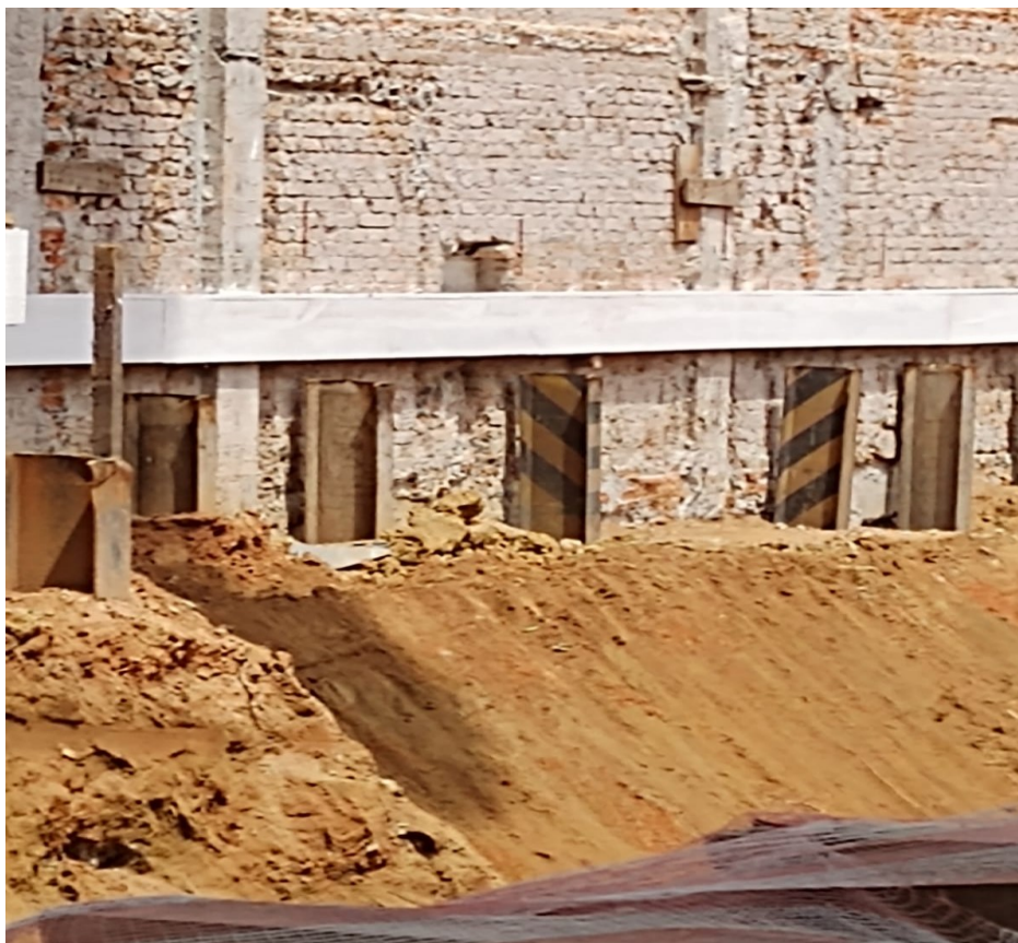
Figura 33 - Reutilização de Perfis Metálicos na Obra Rua Espanha
