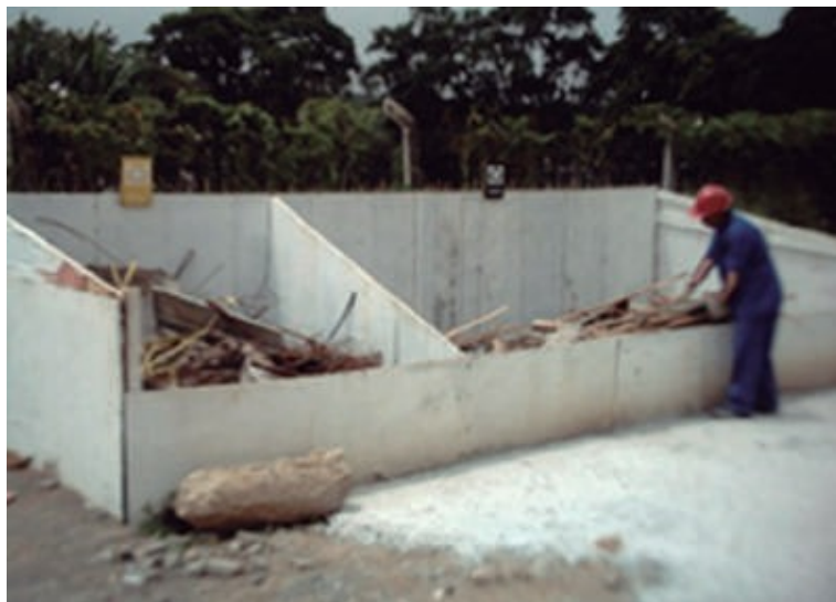
Figura 22 - Baias sinalizadas para acondicionar resíduos de madeira e metal
