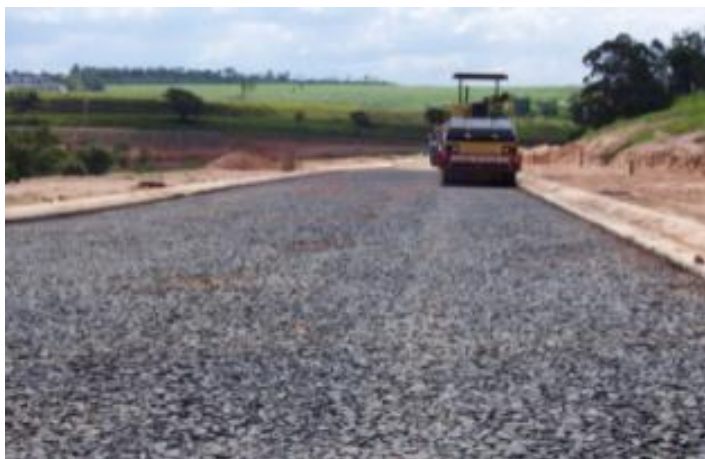
Figura 4 - Utilização em pavimentação
