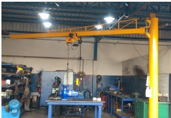
IMAGEM 15 (PÓRTICO ARTICULADO COMPLETA DEPOIS DE MONTADA.)
