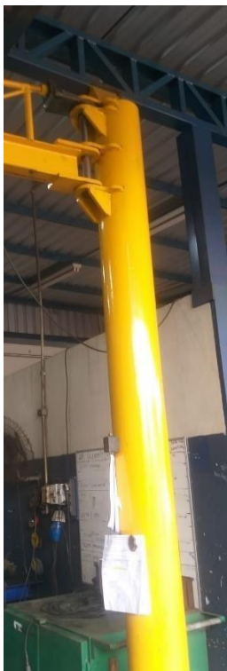
COLUNA DE SUSTENTAÇÃO FIXADA NO CHÃO.
