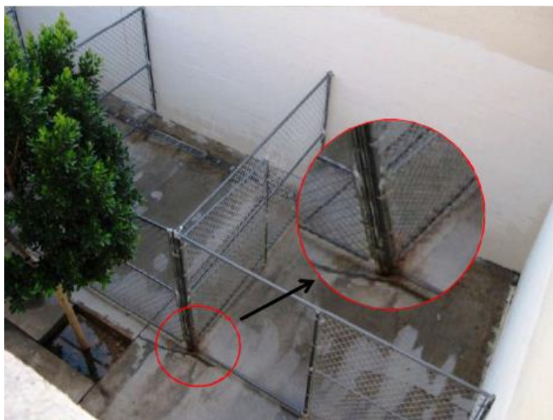
Imagem 49 – Telas do solário galvanizadas
