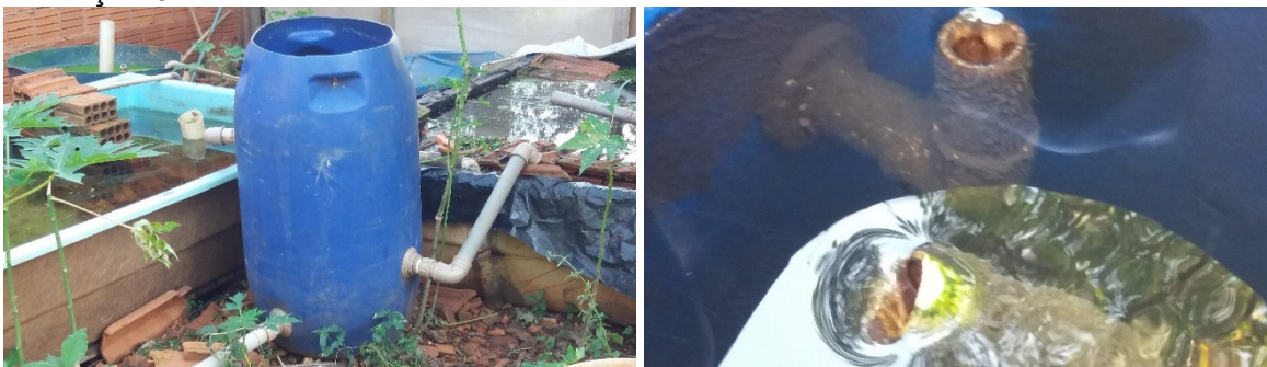
Ilustração 07. Decantador de sólidos.
