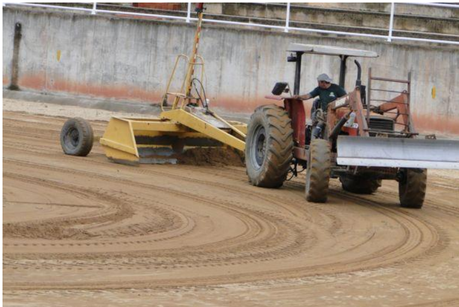
FIGURA 33: Nivelamento a Laser em Campo de Futebol.
