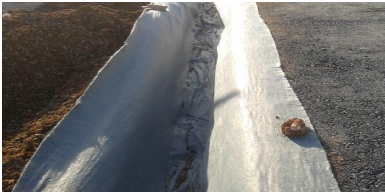
FIGURA 30: Colocação da Manta Geotêxtil.
