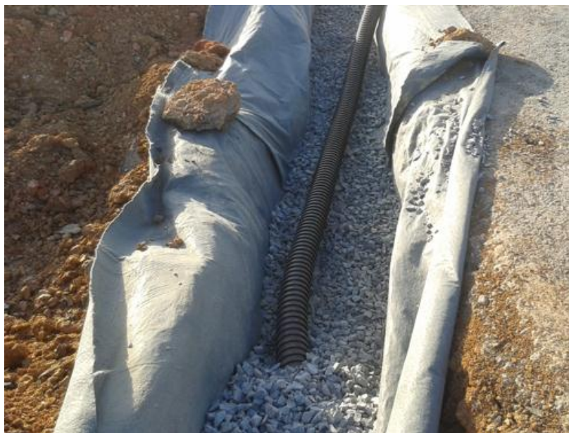
FIGURA 31: Enchimento com Brita e Instalação do Tubo Dreno FONTE: SITE PEDREIRÃO.
