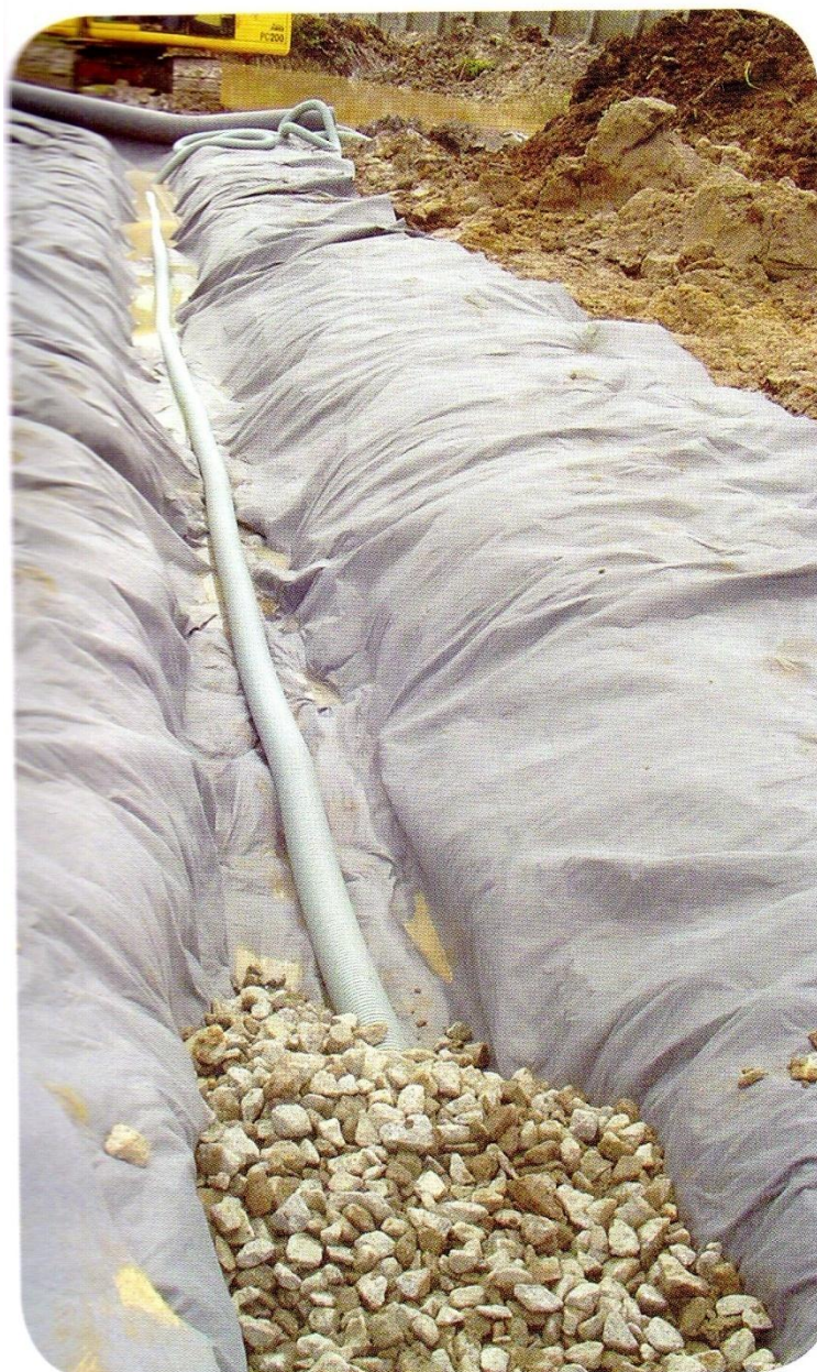
FIGURA 36: Instalação da Manta Geotêxtil
