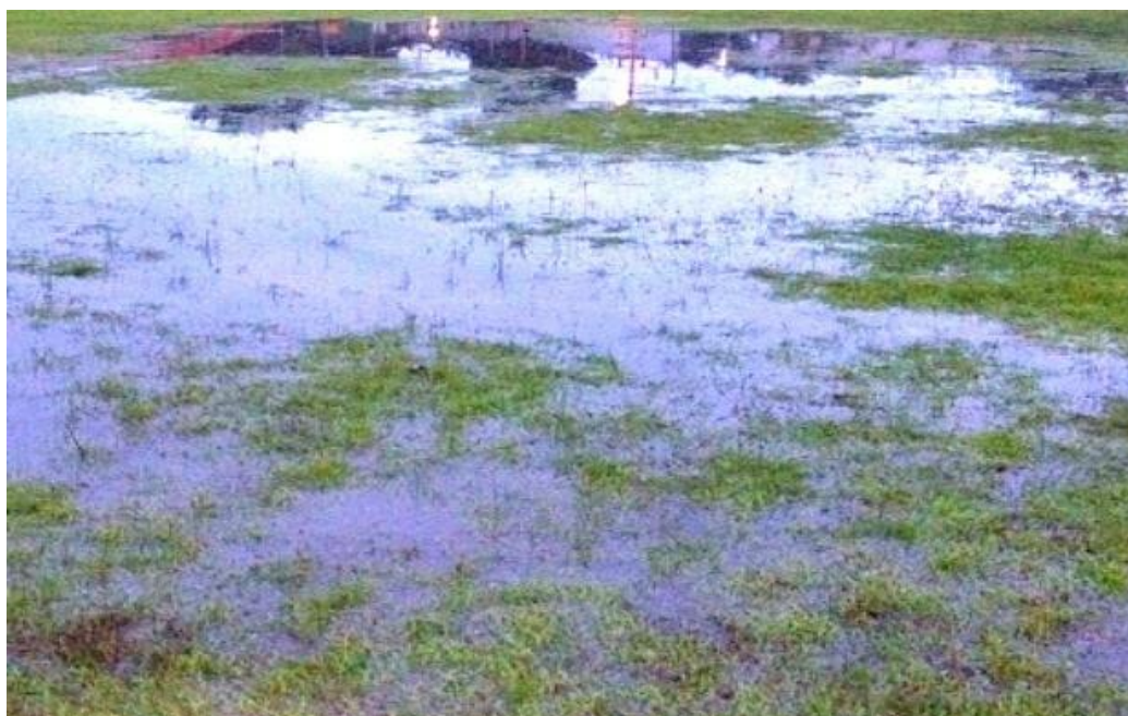
FIGURA 19: Campo sem “caimentos” Necessários e com água de chuva não removida
