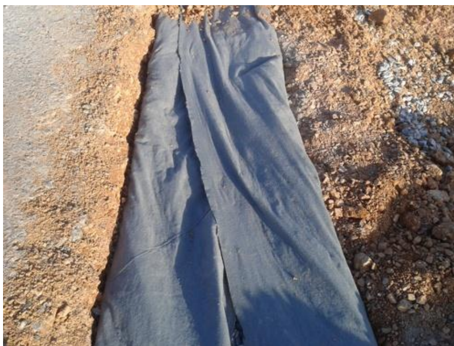
FIGURA 32: Fechamento da Manta Geotêxtil. FONTE: SITE PEDREIRÃO
