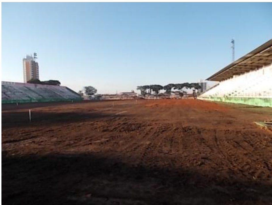
FIGURA 44: Início da Marcação com Estacas no Campo Antes do Topsoil
