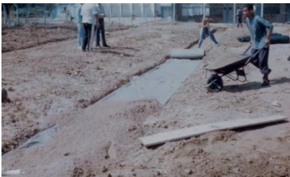
FIGURA 35: Instalação do Geocomposto Drenante
