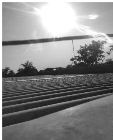
Figura 9 – Telhado de Fibrocimento
