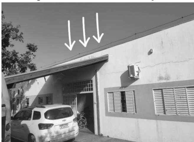
Figura 8 – Local exato da instalação
