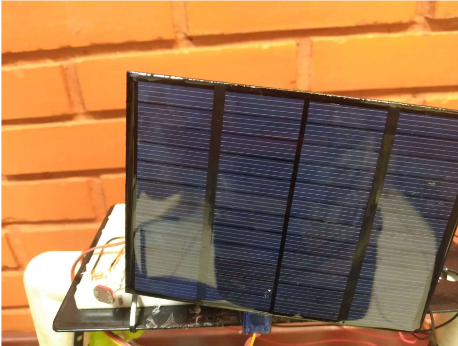
Figura 5 – Detalhe da instalação da placa fotovoltaica
