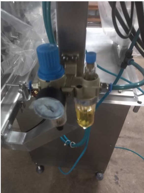
Figura 46 Processo de Montagem
