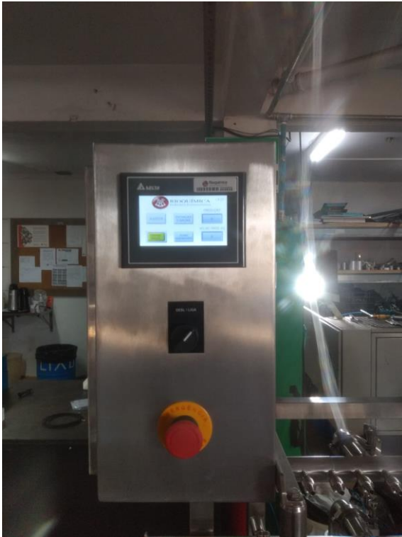
Figura 48 Processo de Montagem
