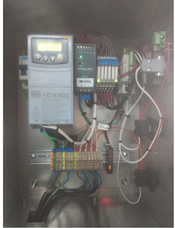
Figura 49 Processo de Montagem
