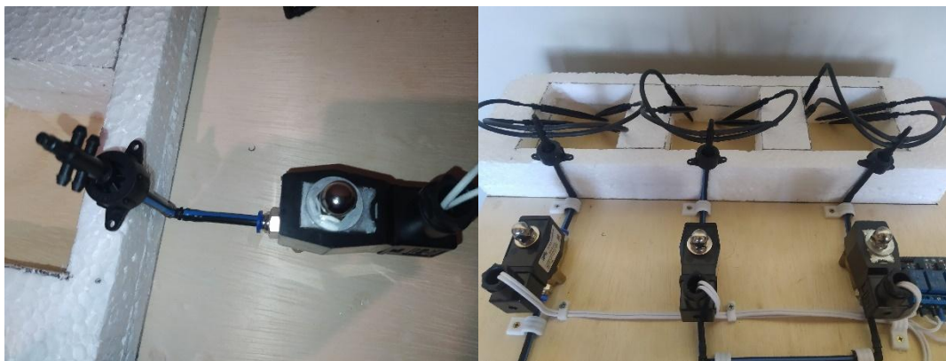
Figura 42 – Montagem dos gotejadores nas válvulas (lado esquerdo) e das estacas gotejadoras (lado direito) Fonte: 42 – Autoria própria
