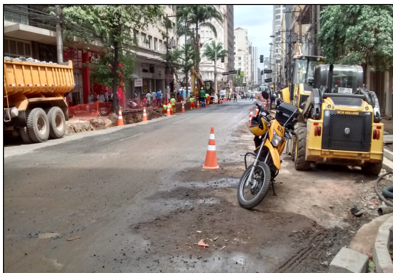
Figura 21: Av. Francisco Glicério passando por obras no centro de Campinas. Fonte: Foto realizada pelo autor, 2015.
